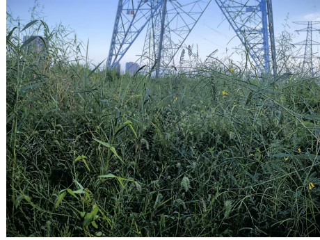
图 5-6 48#塔基环境现状
