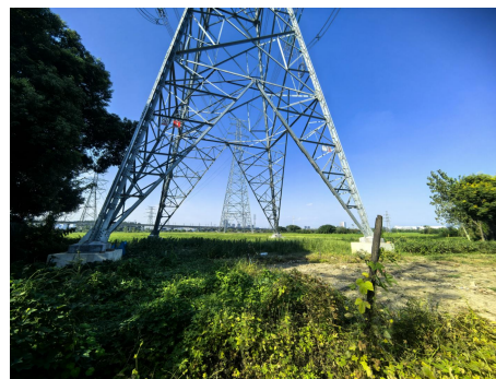
图 5-2 58#塔基环境现状
