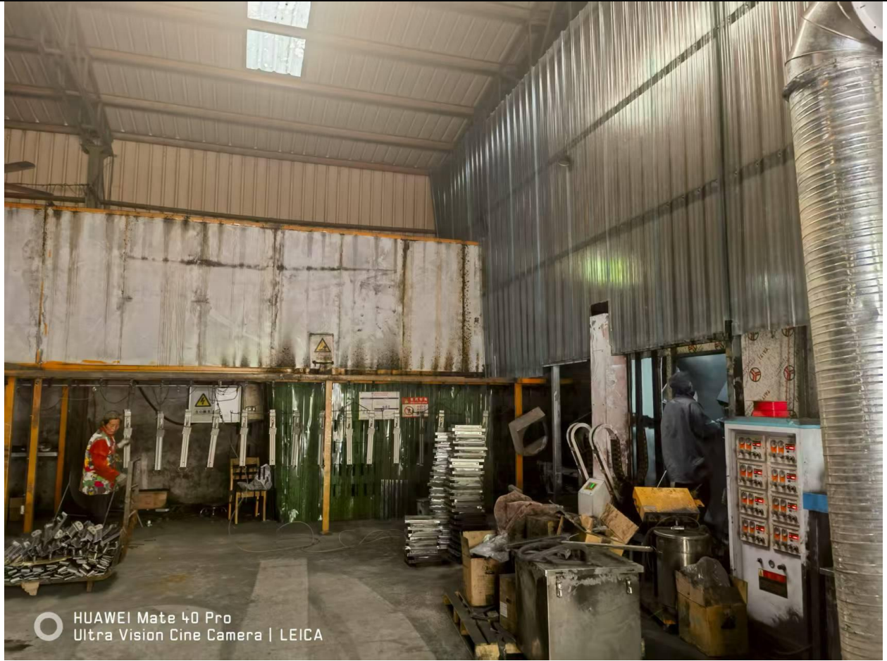
图7 车间局部图（喷涂固化区域）
