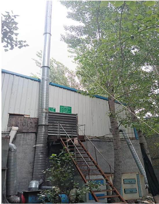
图5 DA002固化、烘干废气排气筒出口
