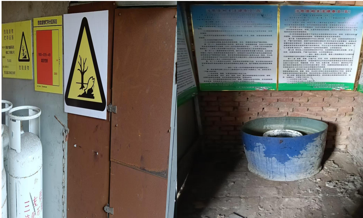
图8 危废暂存间外部
