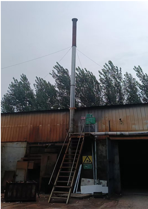
图 3 DA001 喷塑、抛丸废气排气筒出口
