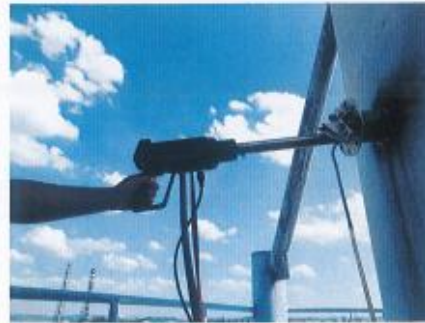
磷酸一铵尾气排口（O2）
