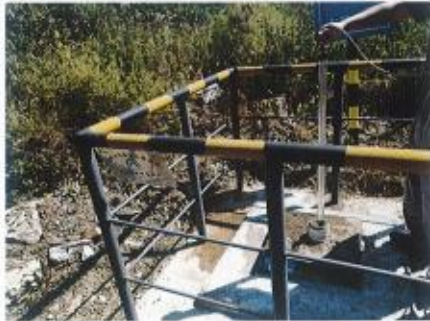
磷石膏渣场及尾矿库地下水监测井 4# (☆5)
