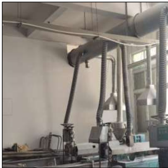
废气收集设施现场照片
